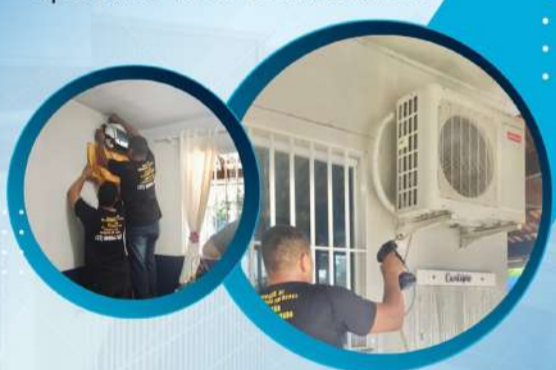
Manutenção e higienização dos aparelhos de ar condicionados
