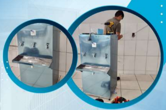
Aquisição e instalação de bebedouro industrial
